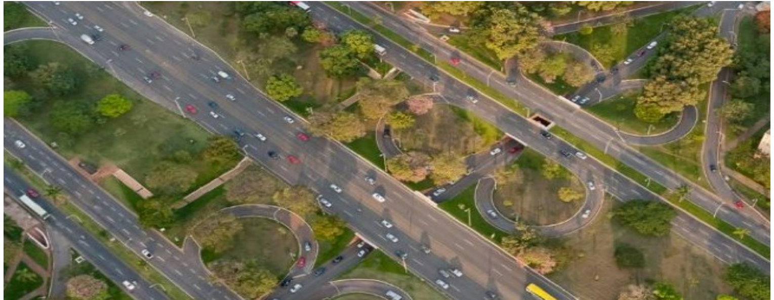
Figura 5. Fotografia aérea de Brasília mostrando as chamadas tesourinhas 1 destinadas aos veículos ao lado de uma das passagens subterrâneas de pedestres.
