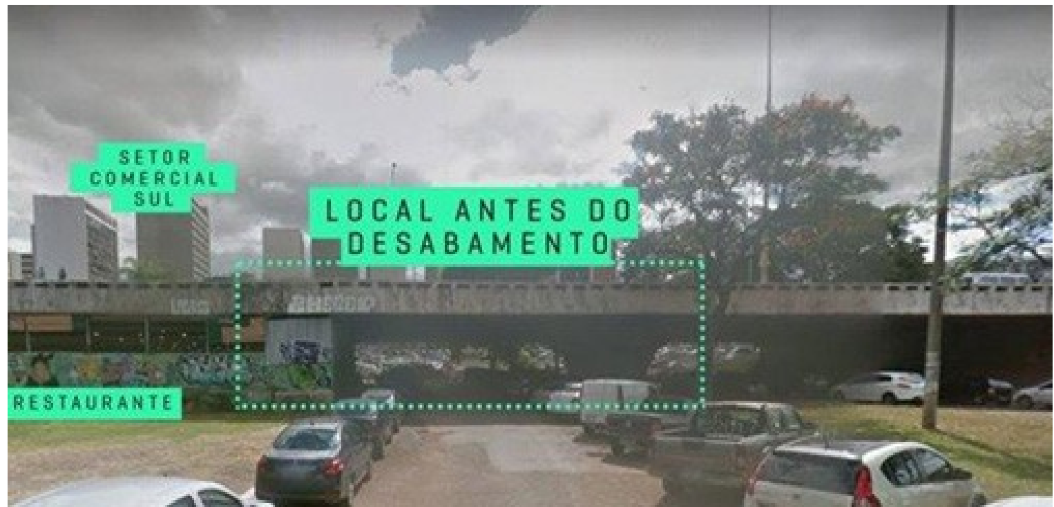
Figura 134. Área de desabamento da Galeria dos Estados.
