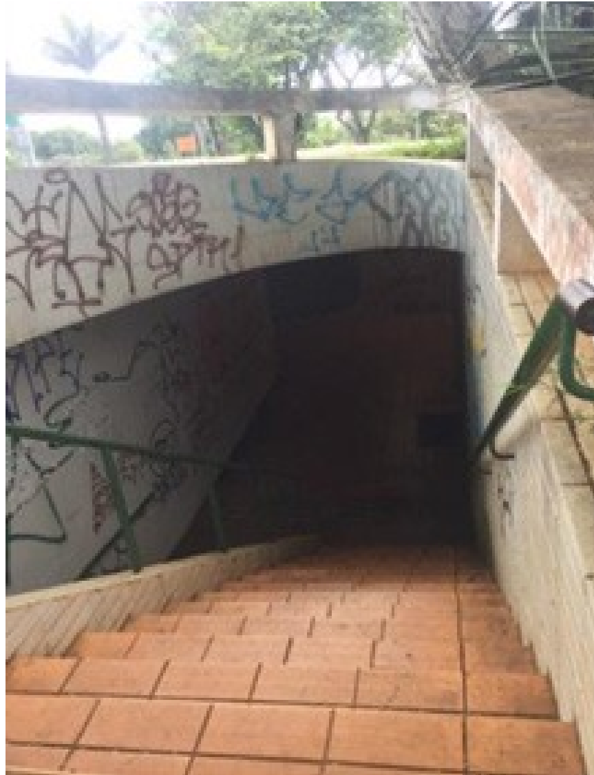
Figura 144. Vista das escadas que dão acesso à Passagem subterrânea Setor Norte que liga os setores SQN 202 – 302.
