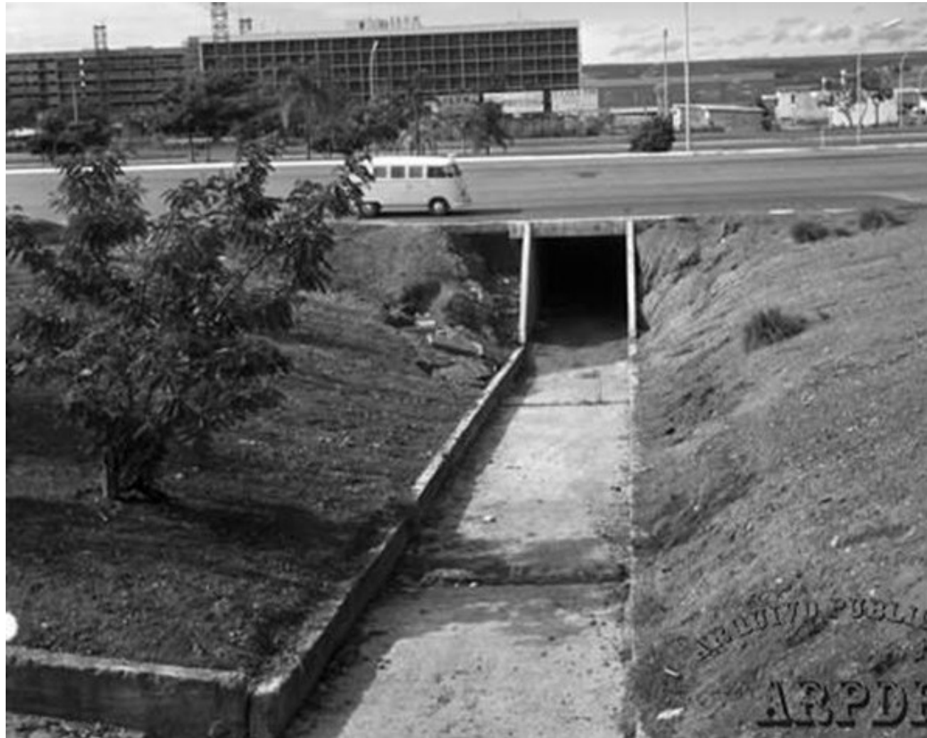
Figura 78. Fotografia da Passagem subterrânea SCS no ano de 1965. Brasília, DF.
