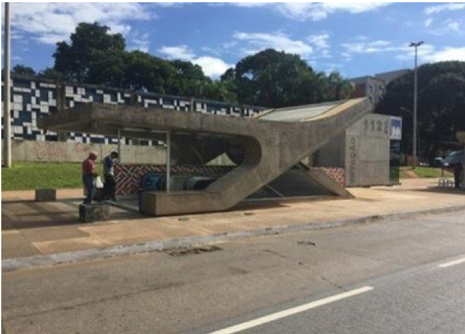
Figura 113. Vista da Entrada da Estação 112.
