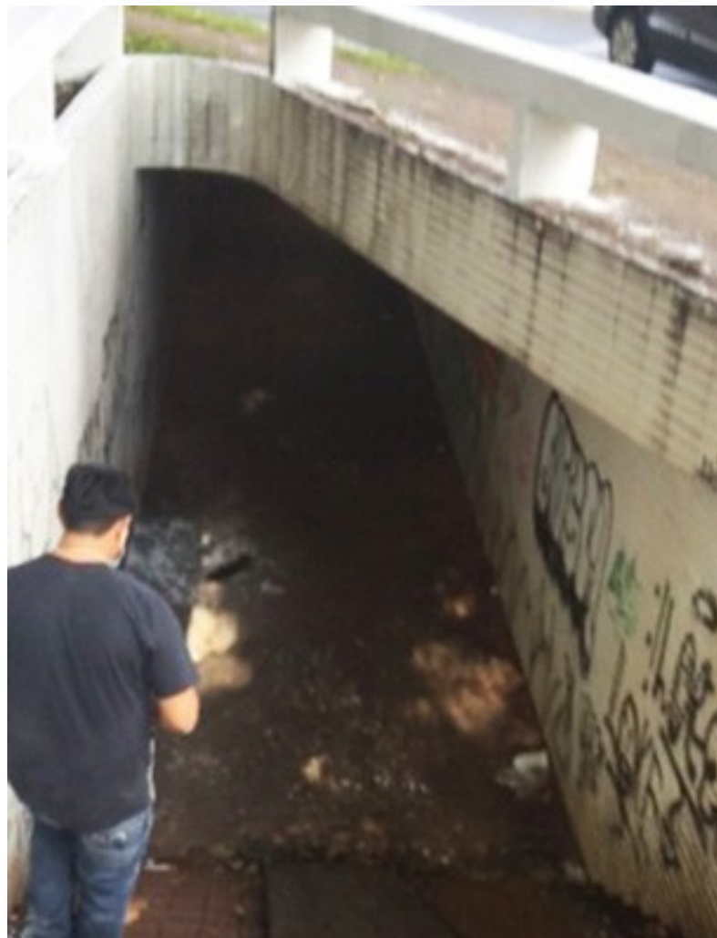
Figura 94. Entrada da Passagem SQS 216-116
