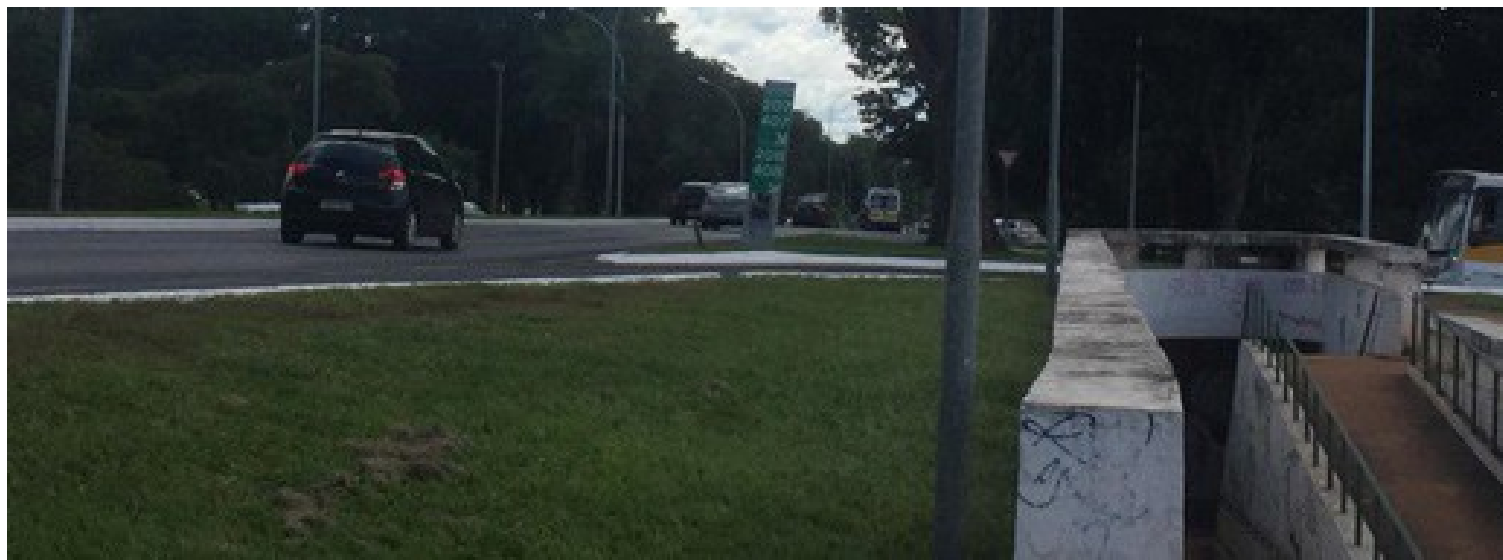
Figura 142. Fotografia escada de acesso. Passagem subterrânea Setor Norte que liga os setores SQN 202 – 302.
