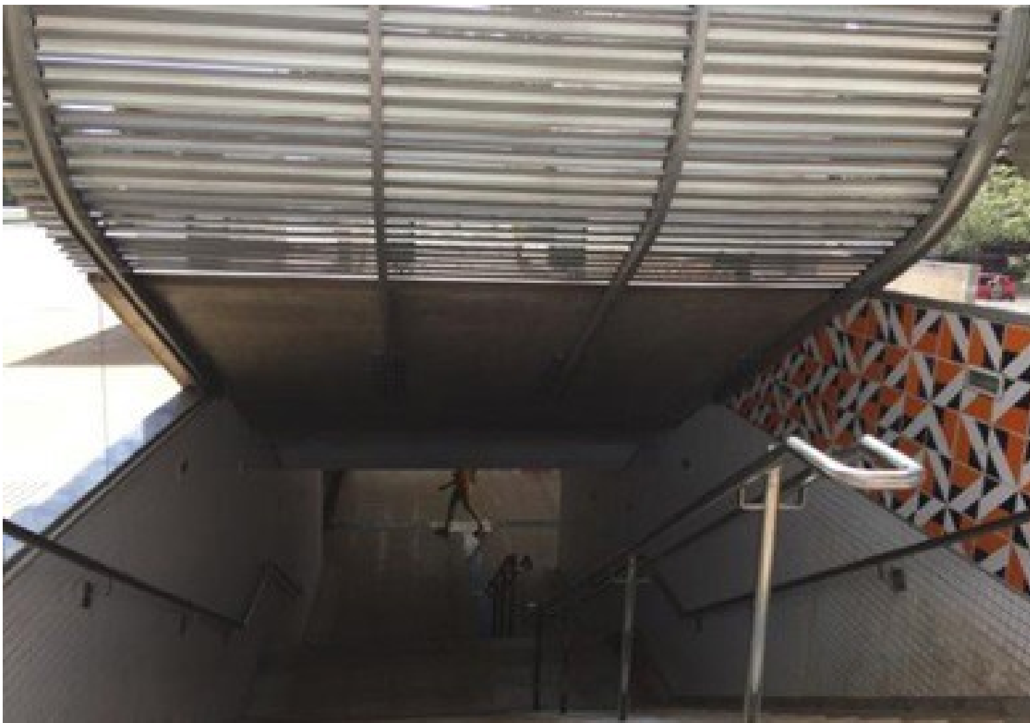
Figura 121. Entrada da Estação 8 a partir do nível do Eixo Rodoviário.
