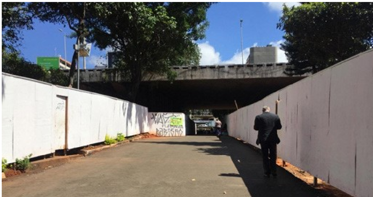
Figura 136. Fotografia área externa Galeria dos Estados mostrando taludes limitadores da obra existente.
