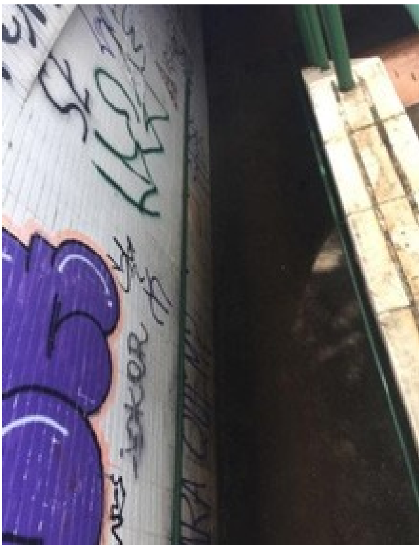
Figura 143. Vista superior da Passagem subterrânea Setor Norte que liga os setores SQN 202 – 302.
