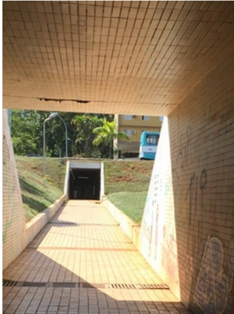
Figura 183. Fotografia mostrando sistema de luz elétrica e sistema de luz natural próximo à saída do primeiro trecho da passagem subterrânea Asa Sul 103-203.
