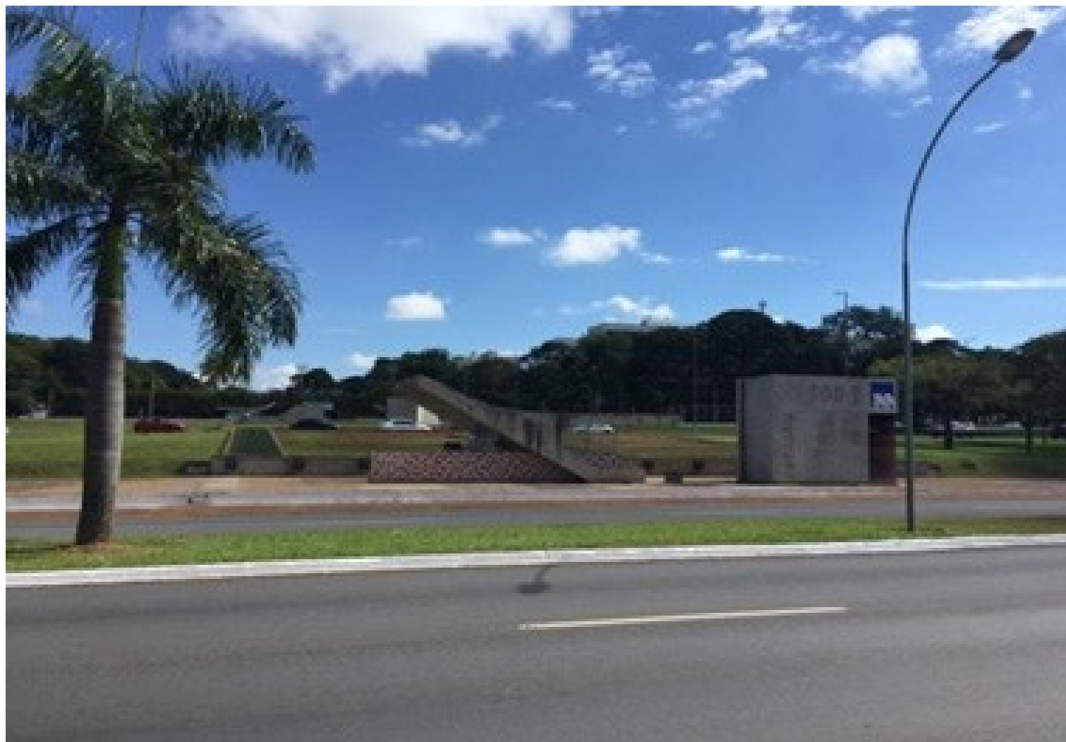
Figura 120. Entrada da Estação 8 a partir do nível do Eixo Rodoviário.
