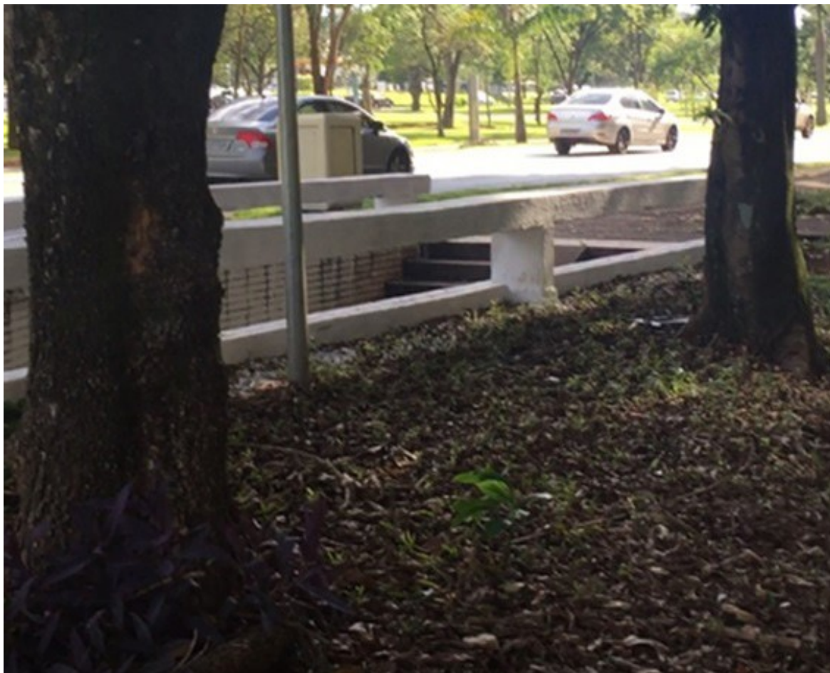
Figura 93. Entrada da passagem SQS 216-116.
