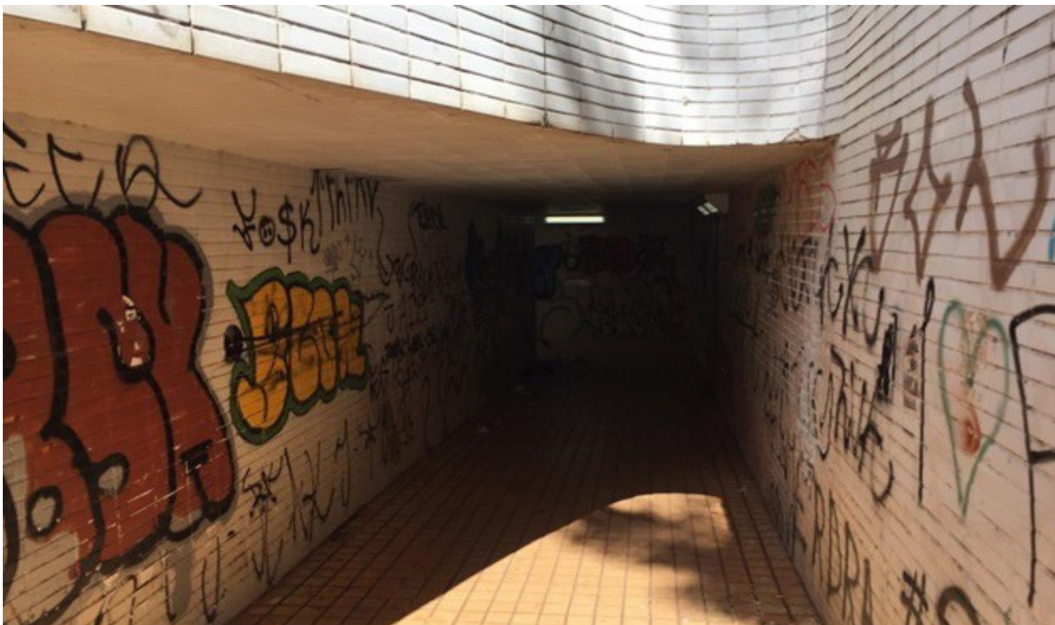
Figura 77. Interior da passagem de pedestres SQN 209-309.
