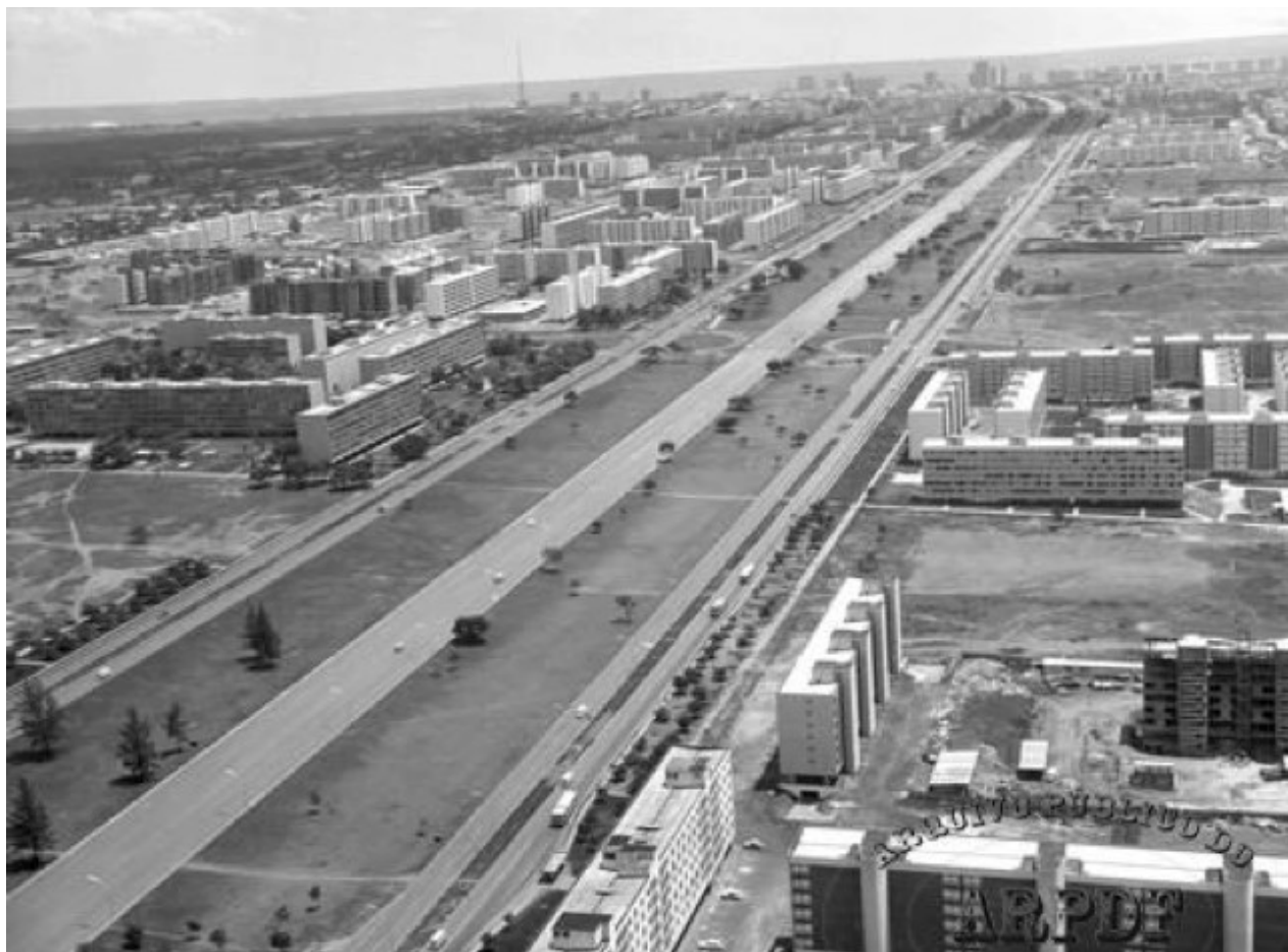
Figura 8. Fotografia do Eixo Rodoviário Sul em 1973.
