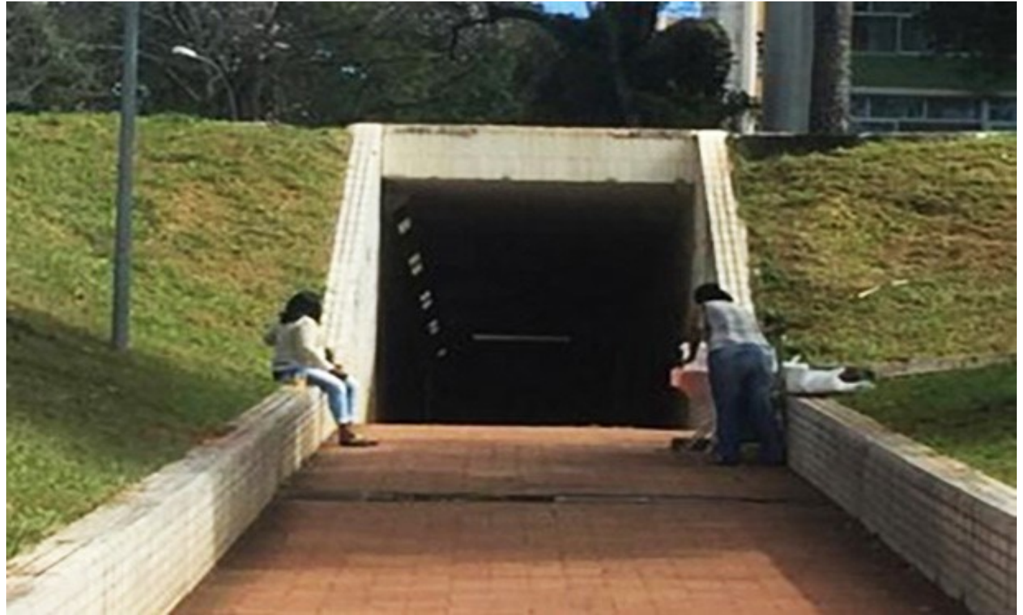
Figura 100. Área externa com vista para o interior do túnel da Passagem SQS 213-113.
