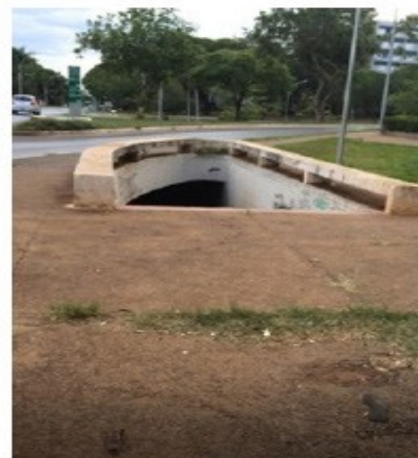
Figura 149. Fotografia da entrada da passagem subterrânea SQS 103.
