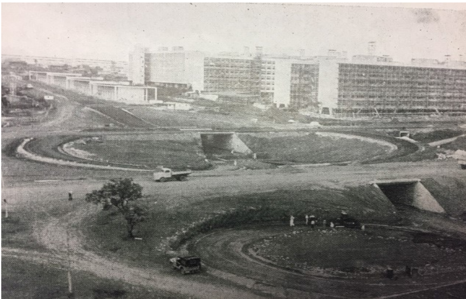
Figura 68. Fotografia Brasília em construção.
