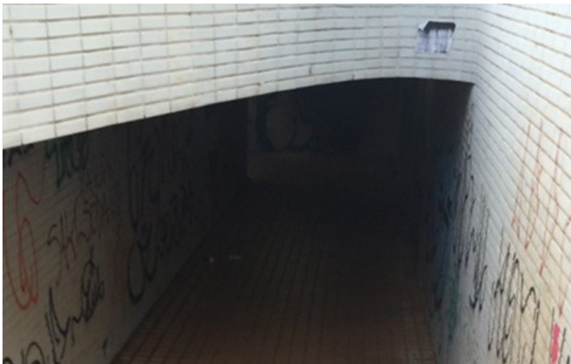
Figura 162. Fotografia término das escadas e início do percurso subterrâneo.
