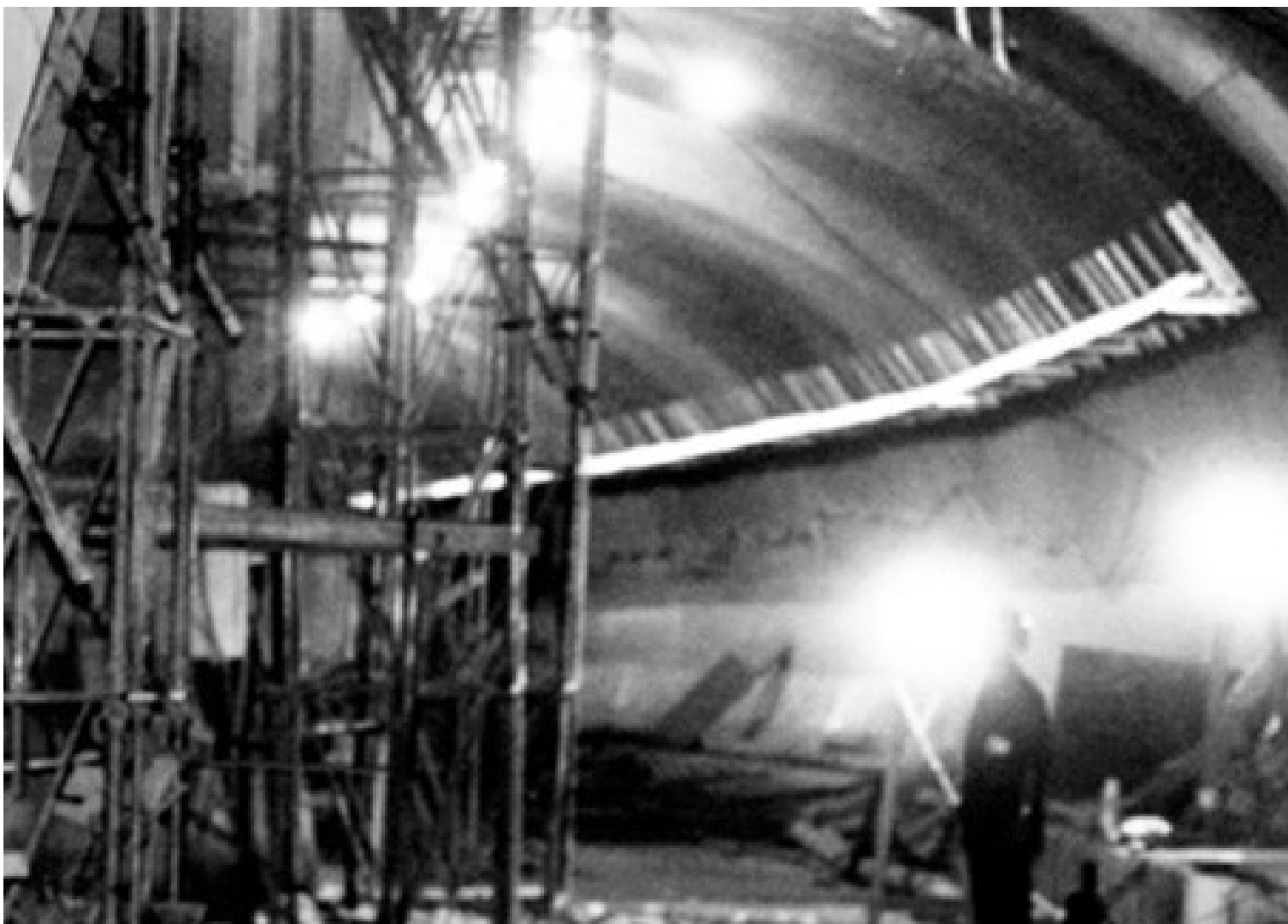
Figura 103. Fotografia da construção de um trecho do metrô de Brasília.
