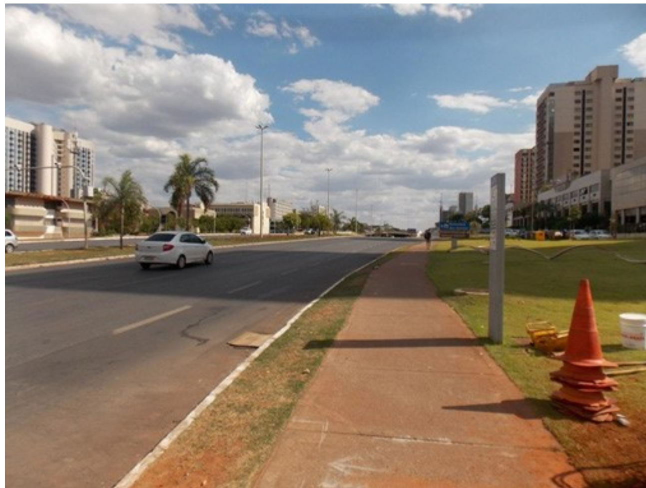
Figura 147. Vista da superfície do conjunto a partir do nível da rua.
