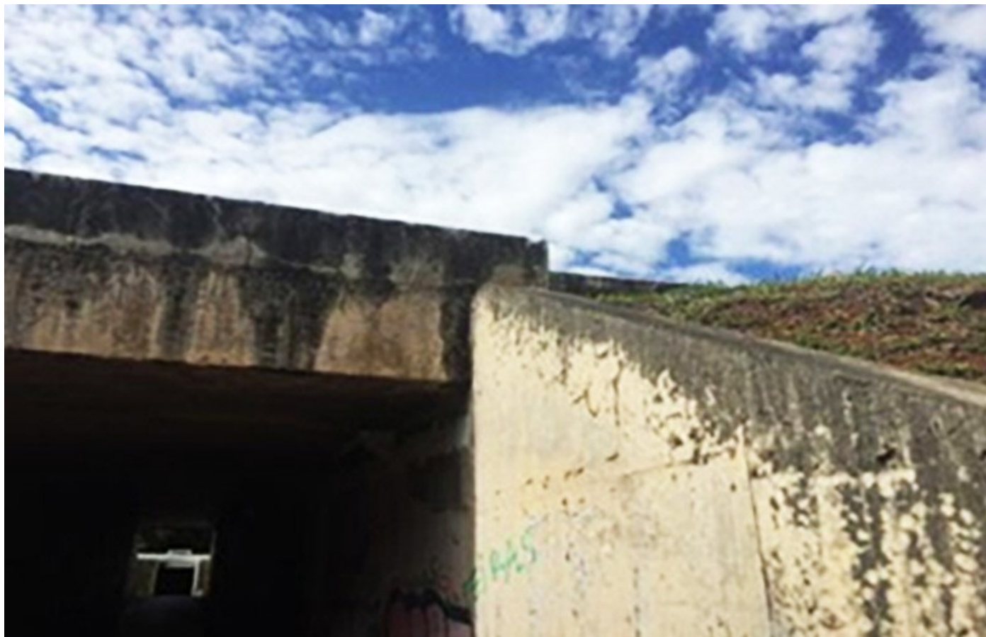
Figura 101. Vista externa da Passagem SQS 213-113.
