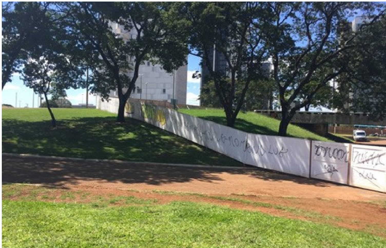
Figura 137. Vista da área externa Galeria dos Estados mostrando taludes limitadores dos eixos dos veículos e dos pedestres.
