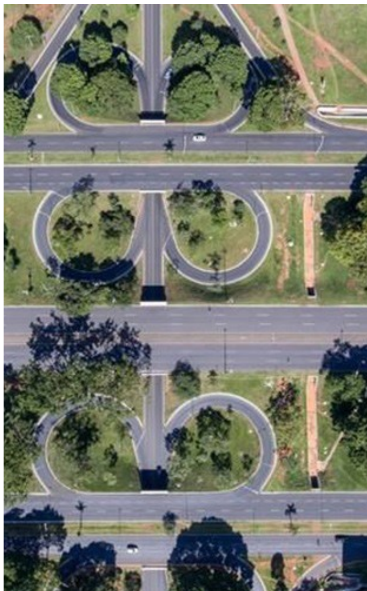
Figura 75. Imagem aérea atual de Brasília mostrando a modificação das passagens com a duplicação das tesourinhas, que passaram a ter quatro alças.
