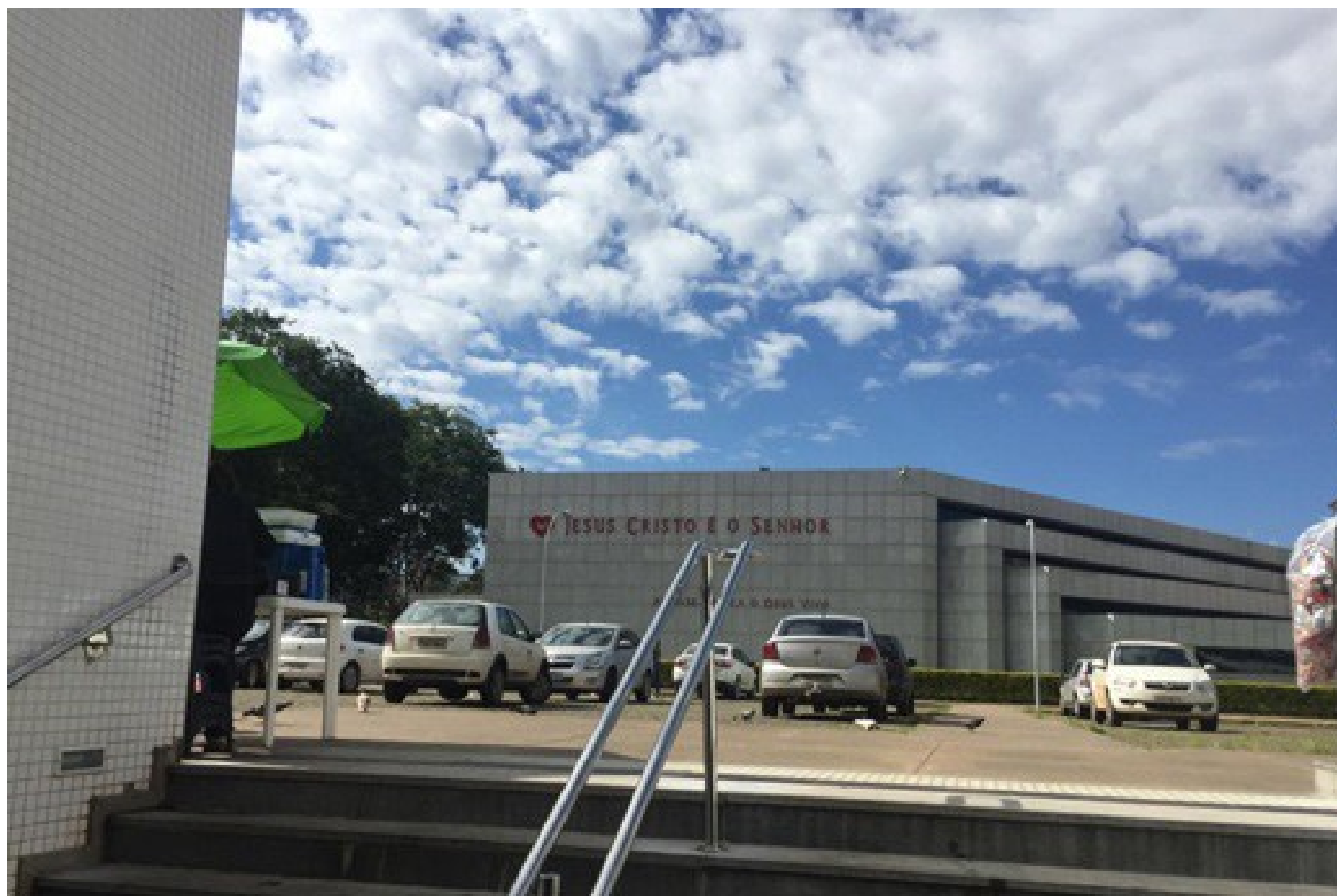
Figura 114. Vista a partir de um dos acessos à superfície da Estação 112.
