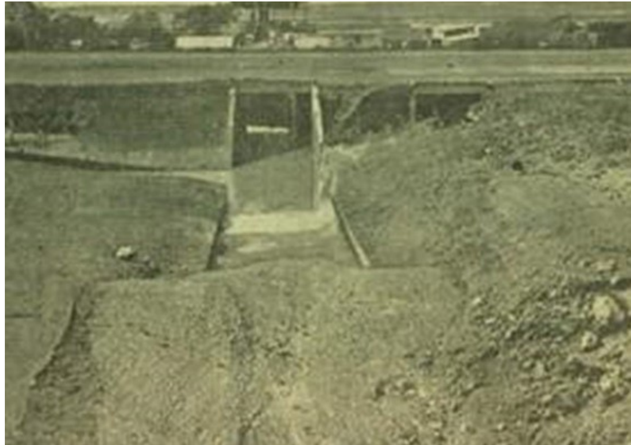
Figura 67. Fotografia mostrando a movimentação de terra durante a construção de uma das passagens subterrâneas de pedestres.
