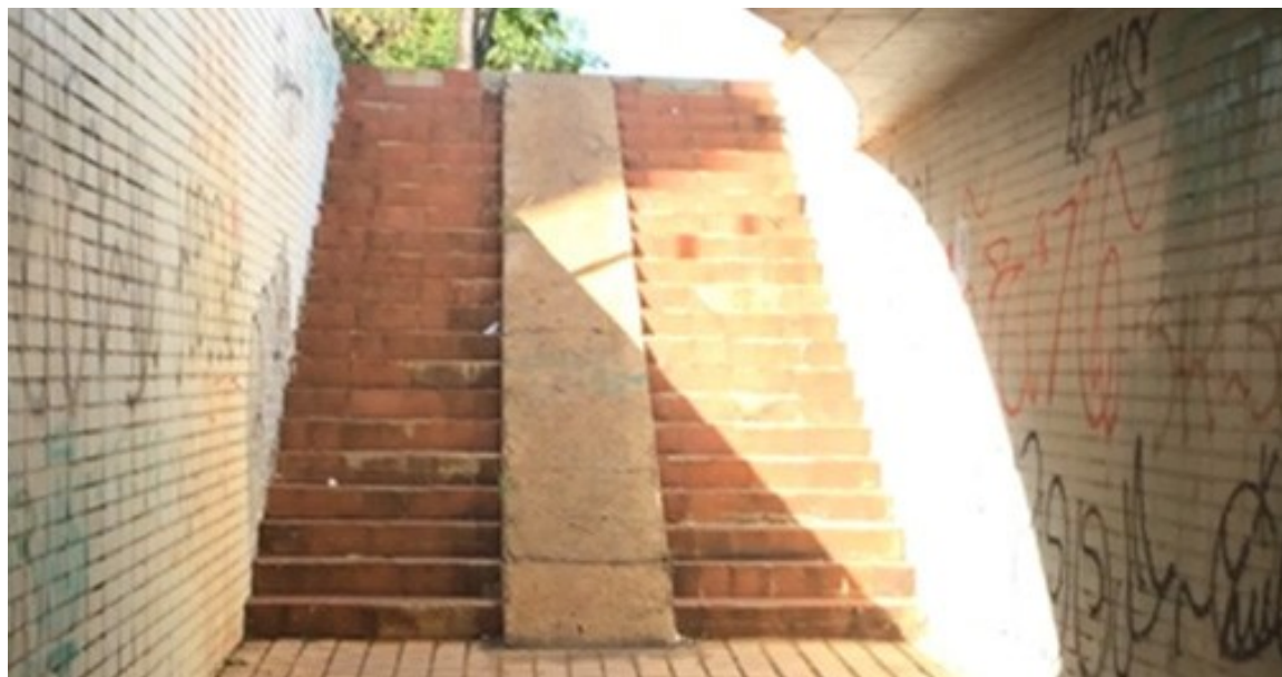
Figura 186. Fotografia da passagem subterrânea Asa Sul 103-203.
