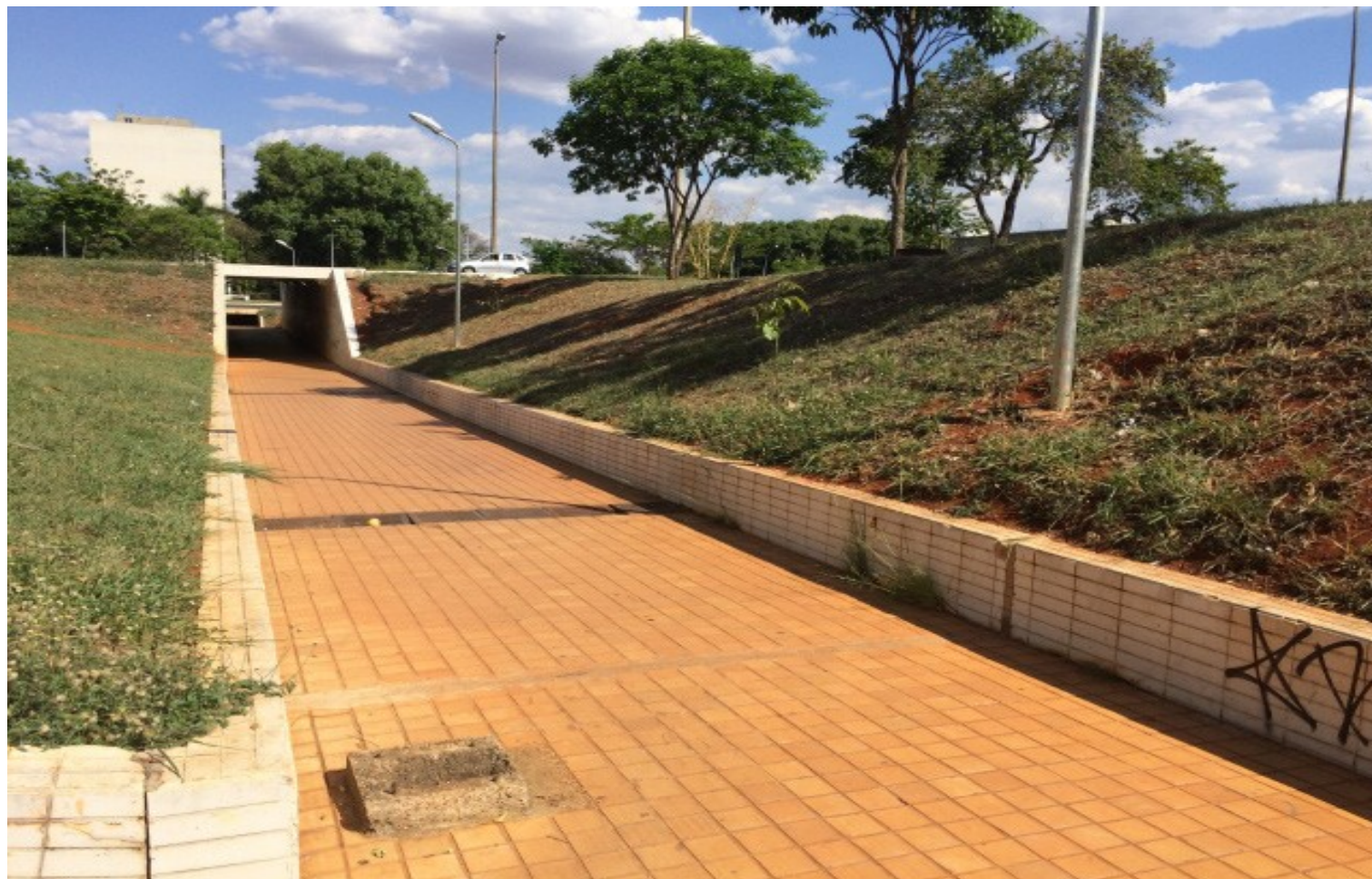
Figura 55. Passagem subterrânea Asa Norte que liga os setores 107-207.
