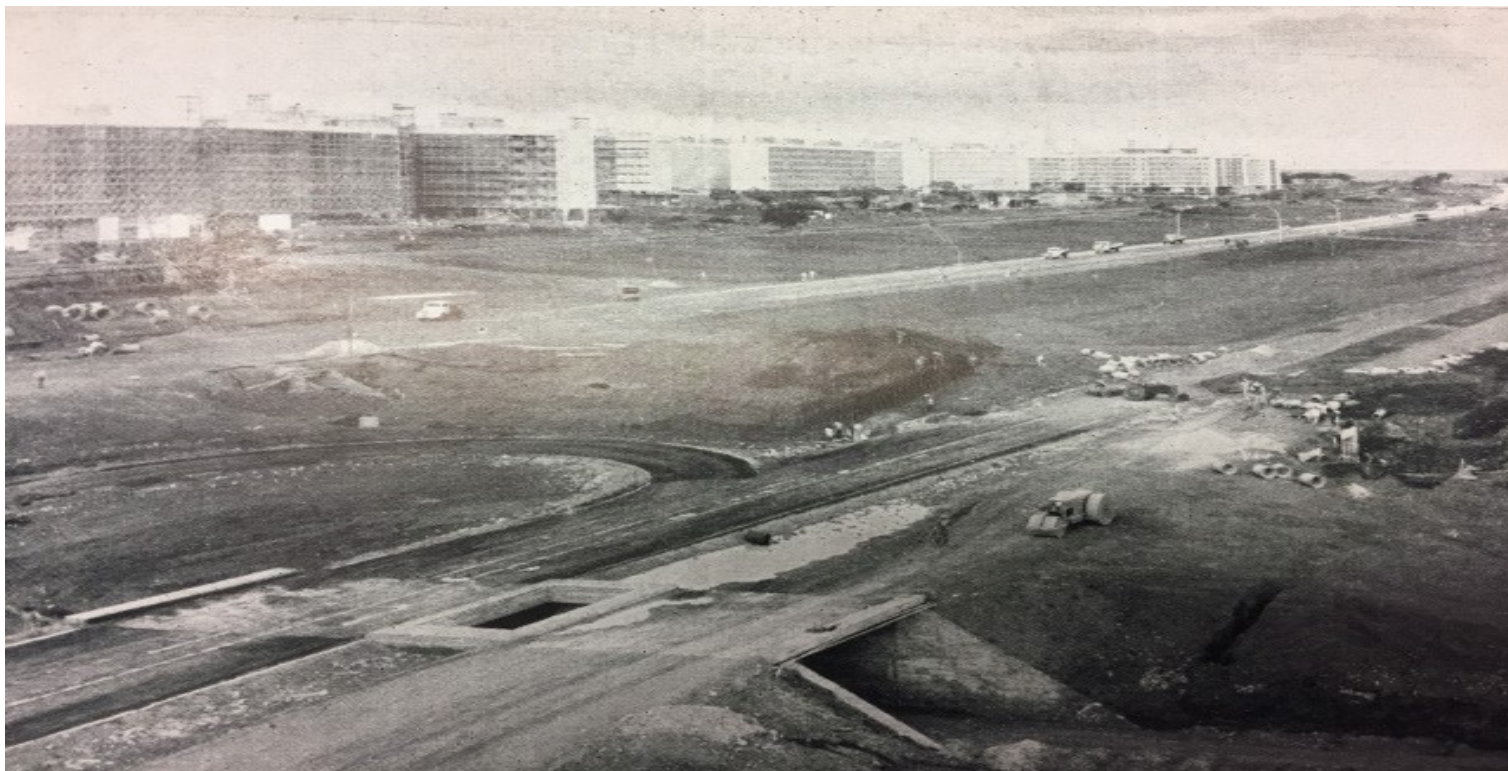
Figura 69. Fotografia Brasília em construção.
