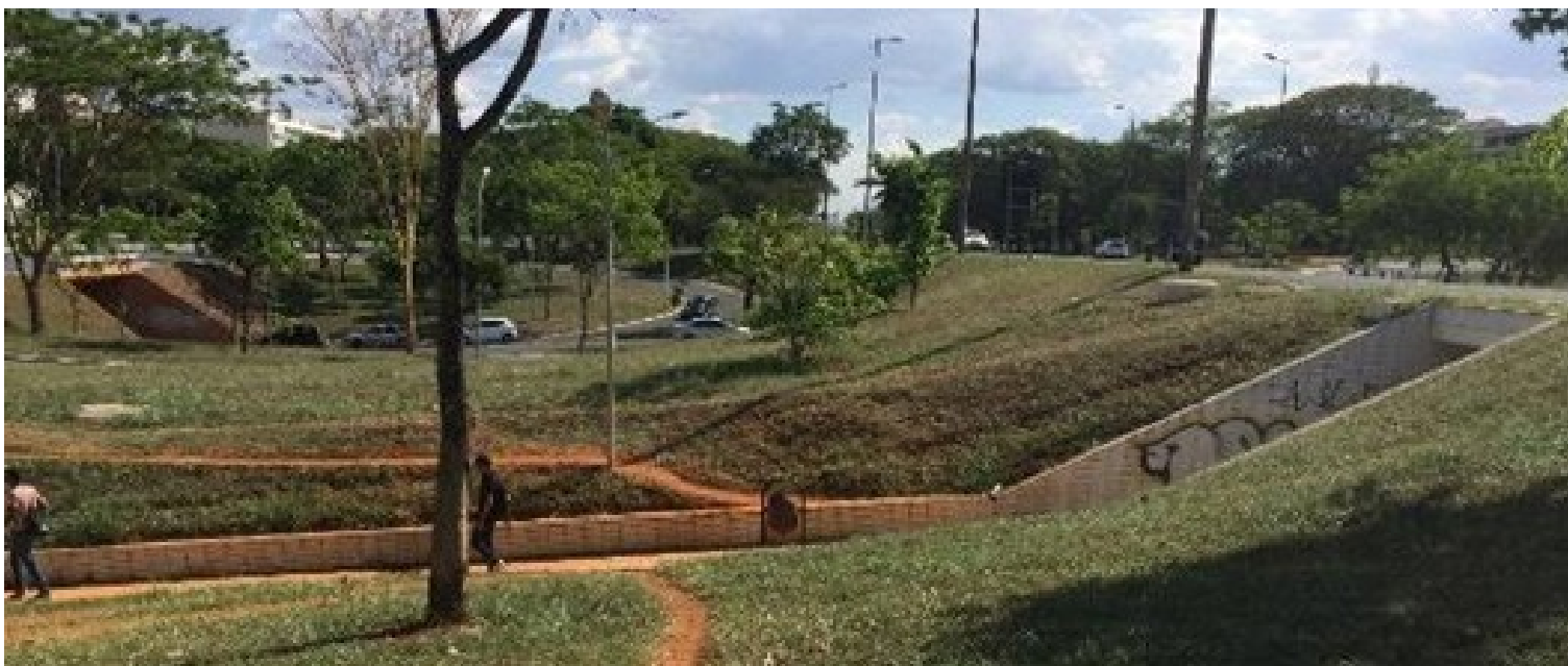
Figura 56. Passagem subterrânea Asa Norte que liga os setores 107-207.
