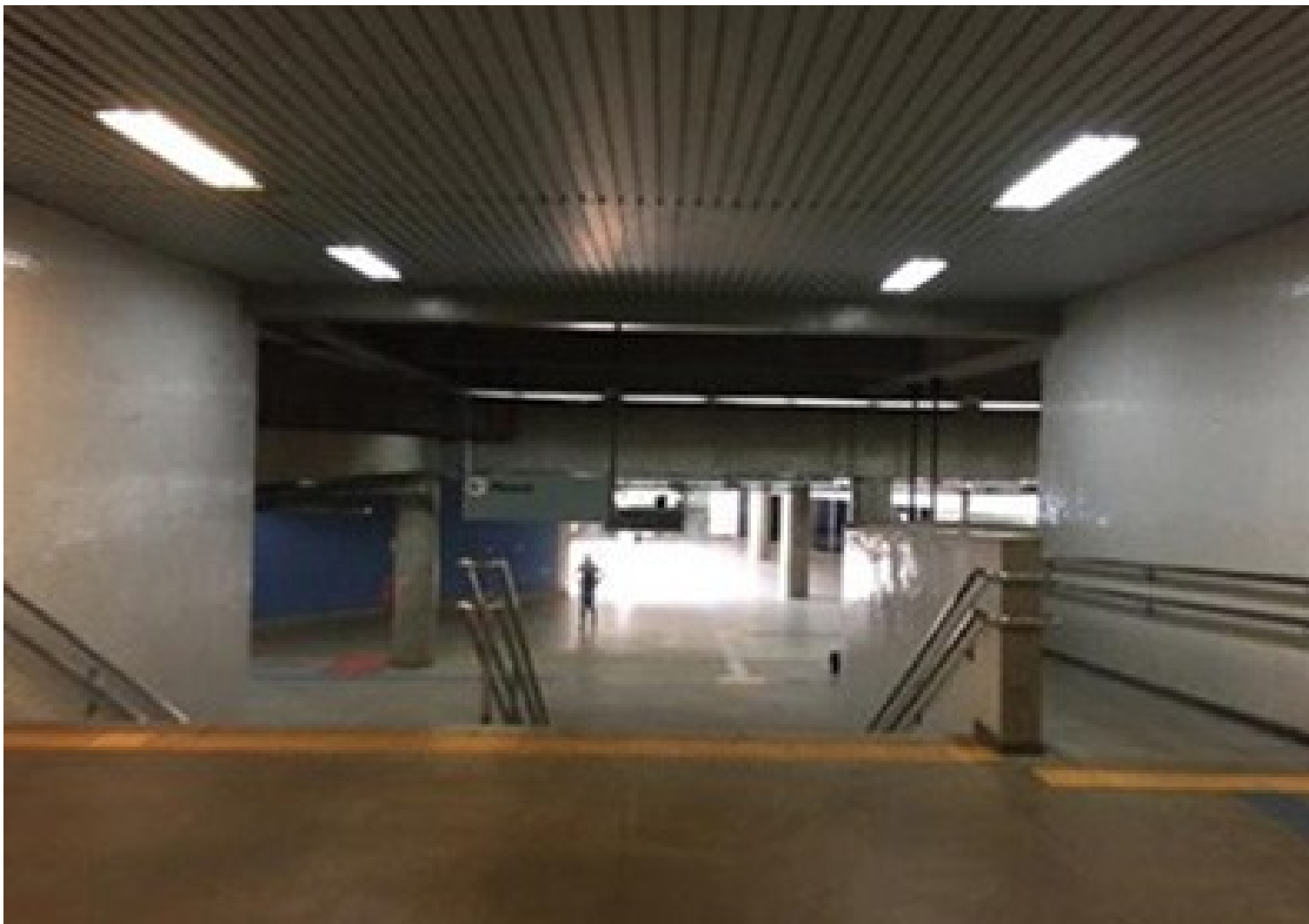
Figura 109. Interior da estação 12 mostrando desnível interno
