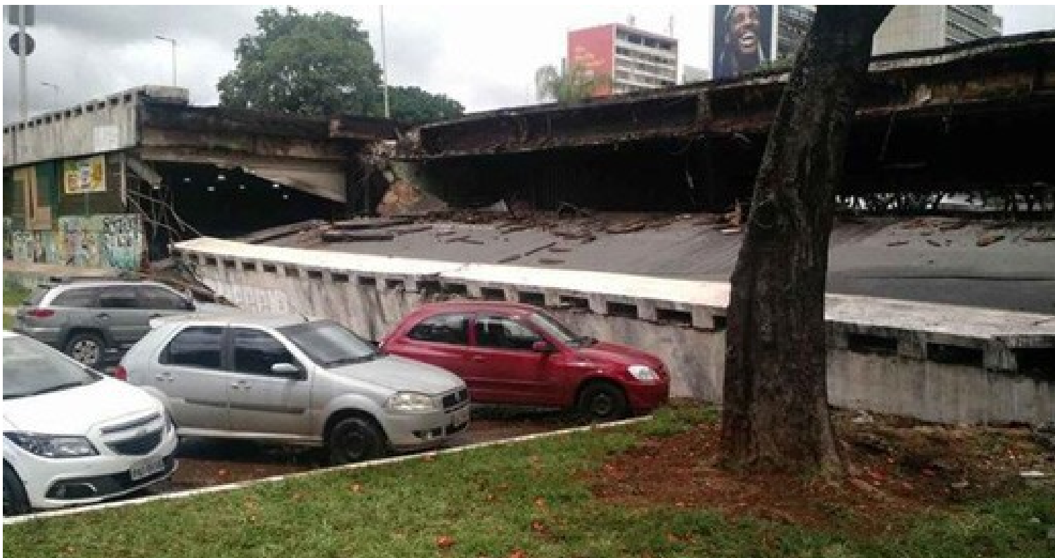
Figura 135. Fotografia da Galeria dos Estados logo depois do acidente.
