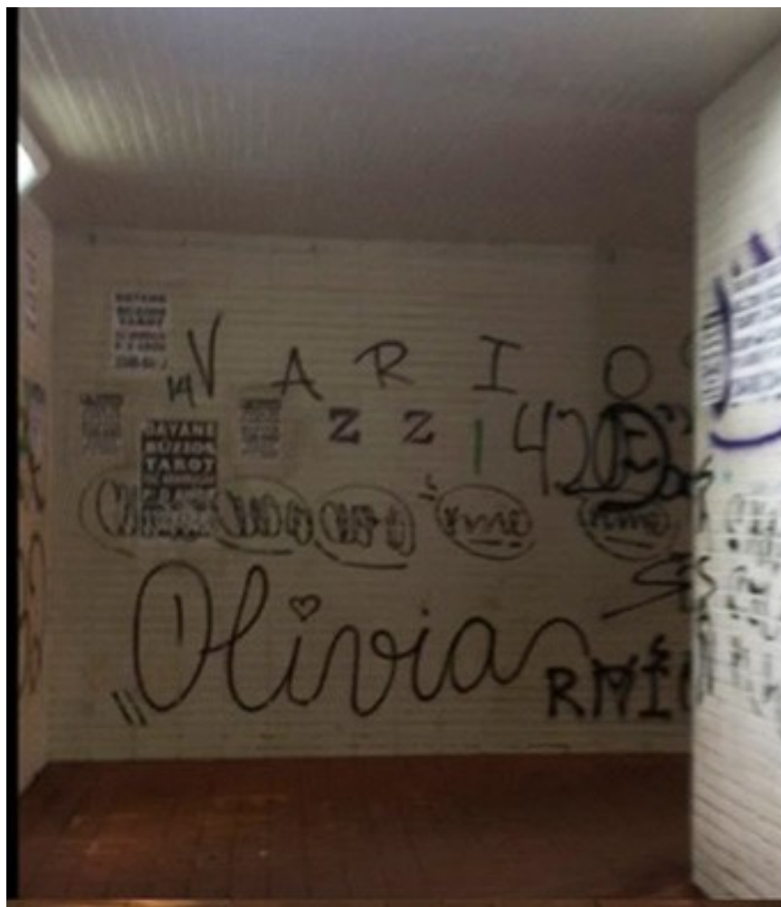
Figura 97. Esquina no interior da Passagem SQS 216-116
