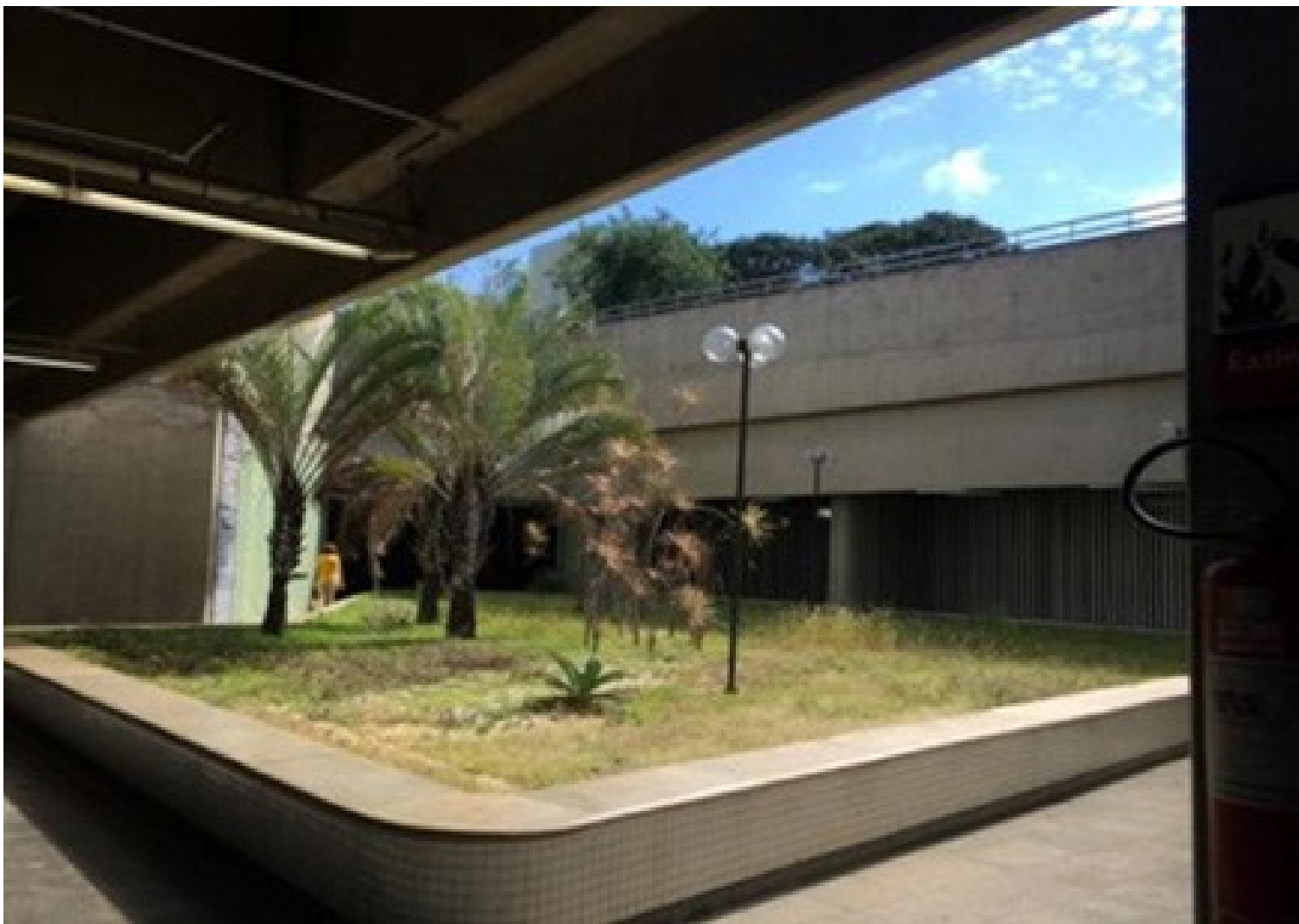
Figura 123. Entrada da Estação 8 a partir do nível do Eixo Rodoviário.
