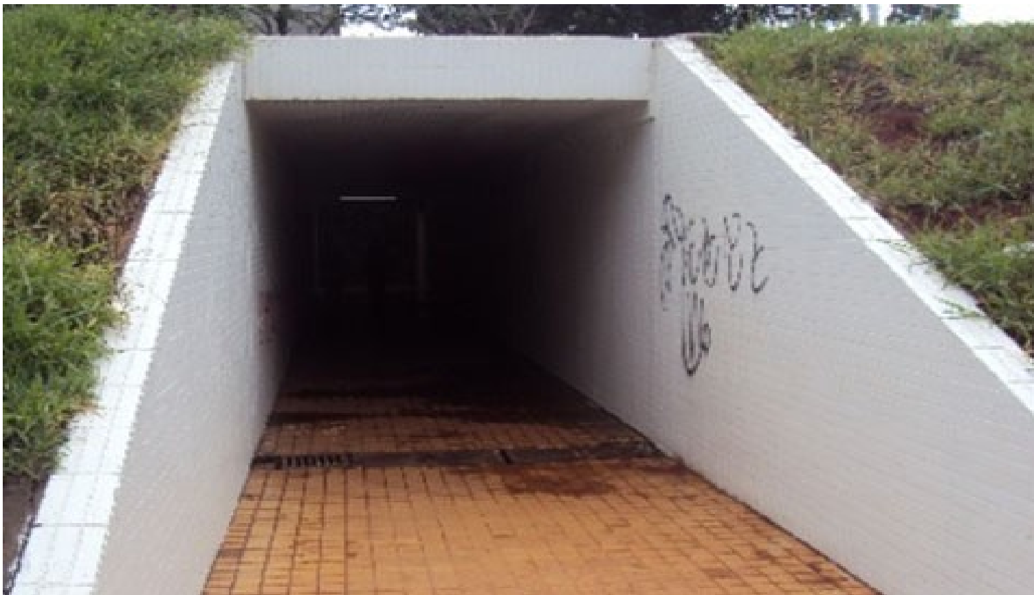
Figura 11. Passagem que liga o Setor Bancário Sul ao Hospital da Base.
