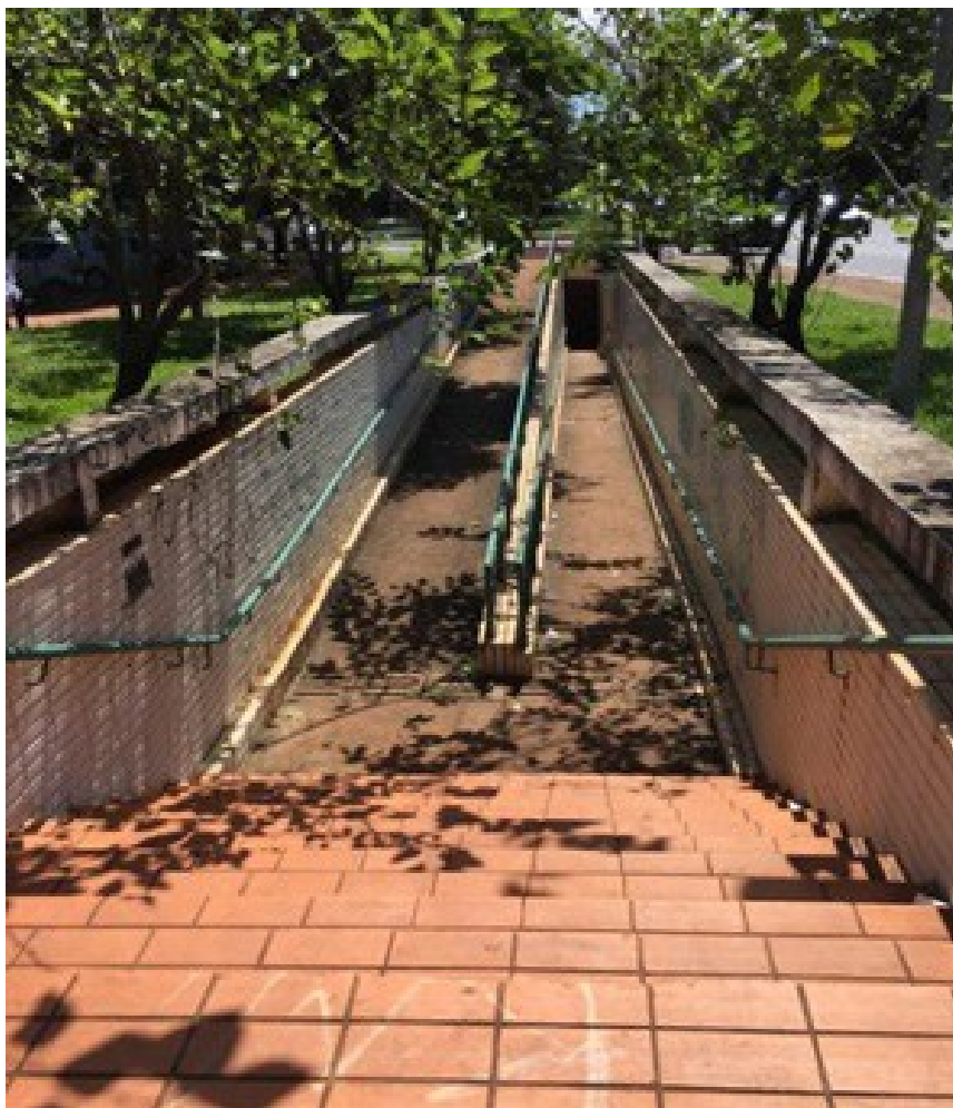
Figura 140. Fotografia escada de acesso Passagem subterrânea Setor Norte que liga os setores SQN 202 – 302.
