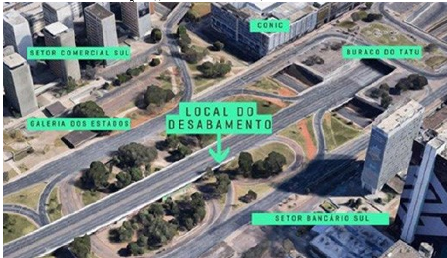
Figura 133. Área de desabamento da Galeria dos Estados.
